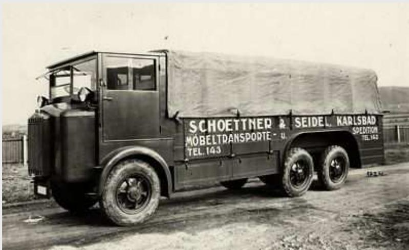
Dem Lastkraftwagenbau räumte Ledwinka ab den 1920er Jahren immer große Bedeutung ein. Seine vielen Erfahrungen im Pkw-Bau übertrug er auf die Lkw, so das Prinzip des Zentralrohres mit angetriebenen, gelenklosen Pendelachsen. Ab 1926 wurde der Lkw Tatra T 30 mit luftgekühltem, vierzylindrigem 1,7 Liter-Boxermotor gebaut.
